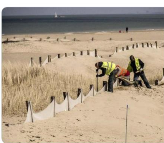
6 La protection du cordon dunaire. Des aménagements en bois (ganivelles) sont installés afin de piéger le sable transporté par le vent. Une fois la dune stabilisée, elle peut accueillir une végétation typique (ici des oyats) qui participe au maintien du sable en place. Les ganivelles préservent les dunes de l'impact du piétinement.
